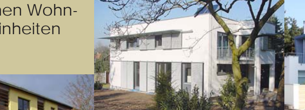
„Aus 1 mach 2“ Erweiterung + Umbau Aschaffenburg
